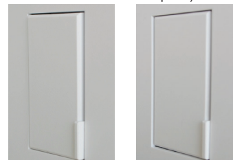
Correcte : Le Gradateur/interrupteur effleure la plaque faciale.
