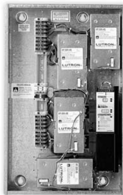
Mini XP Softswitch Panel— 4-16 circuits
